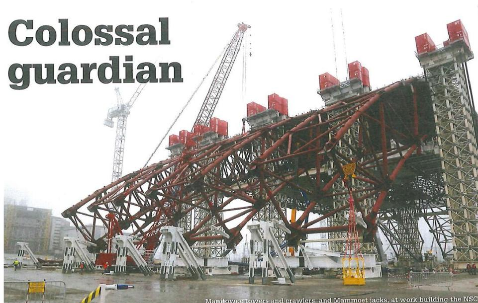
図2 建設途中のNSC構造物の骨組み
